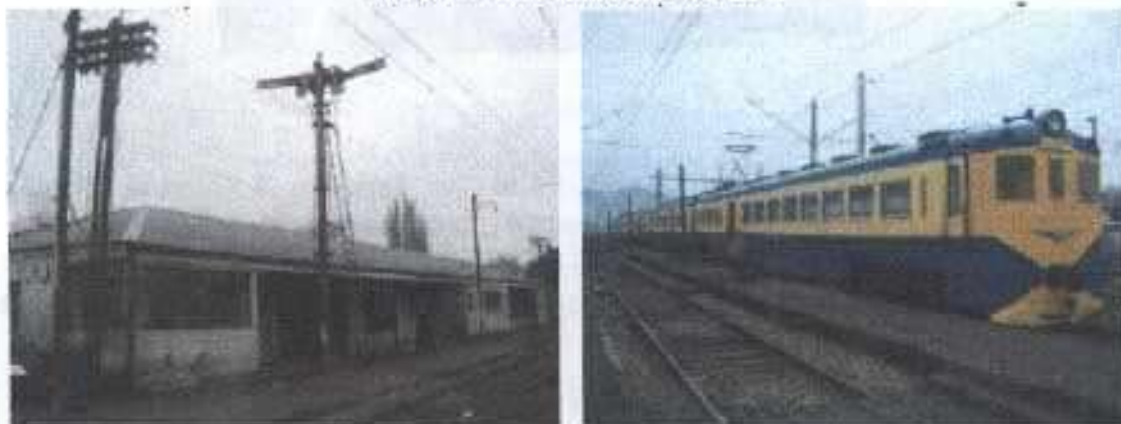
Imagen N° 17: Estación de Laja.
